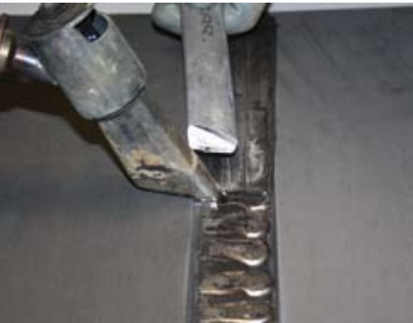
Aanbrengen van een toevoegmetaal
