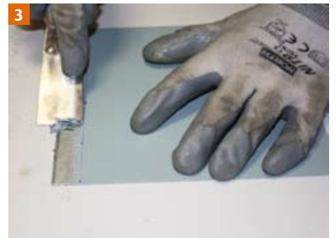
3 Verwijderen van de laklaag met een spatel.
