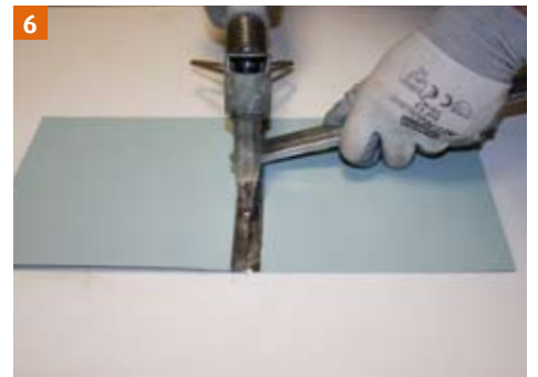
6 Breng ZINN 7 aan over de lengte van de soldeernaad. Aanbrengen van de gladde soldering.
