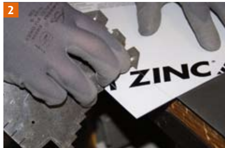
2 Traceer de VMZINC PLUS laag. Verwijder de film van de overlappende delen.
