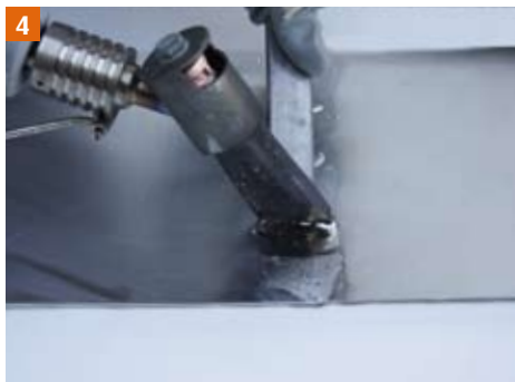
4 Realisatie van een gladde soldering Aanbrengen van extra toevoegmetaal
