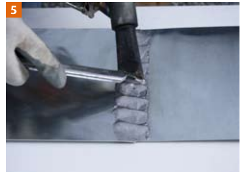
5 Realisatie van een geribde versterkte soldering op de gladde soldering.
