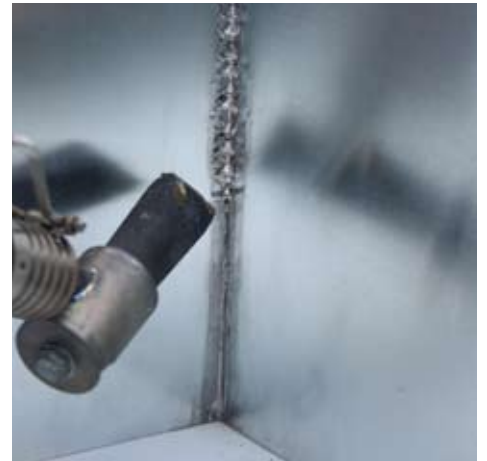
Geribde (versterkte) soldering
