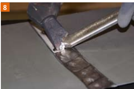
8 Breng ZINN 7 aan over de lengte van de soldeernaad. Solderen over een lengte van ca 4cm in één beweging. Als het soldeersel wit uitslaat (hard is), kan u verder solderen.
