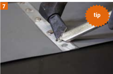
7 Aanbrengen van puntsoldering ZINN 7 over de lengte van de soldering om de 2 platen met elkaar te verbinden.
