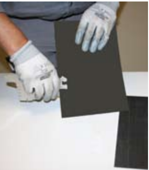
Traceren van de overlappende delen
