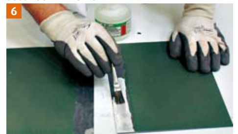
6 Aanbrengen van DECA-VMZINC® om de prepatina-laag te decaperen.
