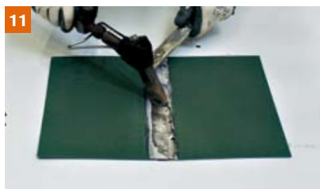
11 Breng ZINN 7 aan over de lengte van de soldeernaad. Soldeer de bladen.
