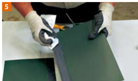
5 Schoonmaken met een droge doek. Stap 3 herhalen op plaatsen waar nog resten PIGMENTO blijven.
