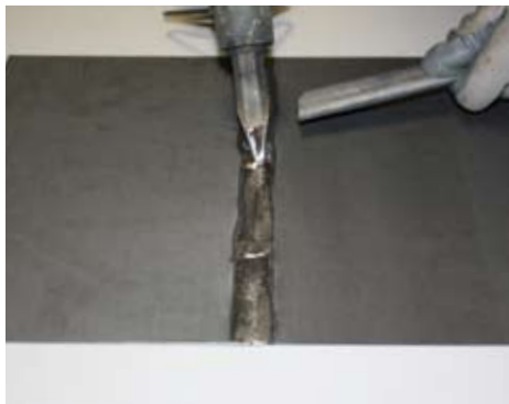
Realisatie van de gladde soldering
